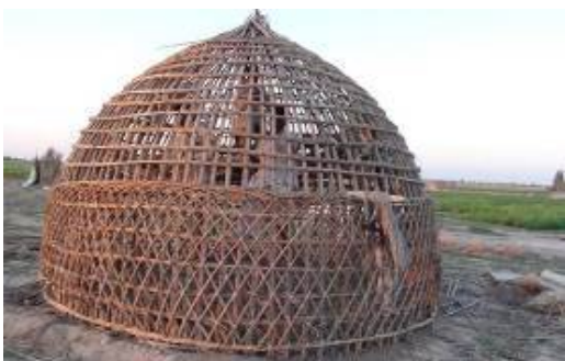
ت 17. مراحل ساخت سقف و دیوار کپر.
