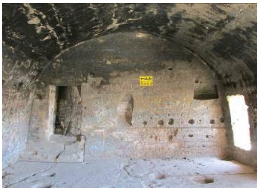
9. پوشش قوسی شکل بخش مصنوعی (دستکند) غار کرفتو (عکس: نگارنده).
