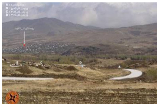
7. نمایی از ورودی‌های فضاهای زیرزمینی مجموعه معماری دستکند ارزانفود همدان. (خاکسار، 1389).
