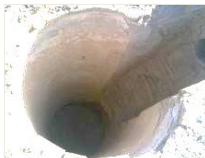
ت 14. تنوره آسیاب موسی در محل اتصال با کانال انتقال آب به آسیاب. منبع: نگارندگان، 1391.
