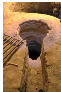
ت 12. تنوره آسیاب ریگاره در محل اتصال با کانال انتقال آب به آسیاب. منبع: نگارندگان، 1392.
