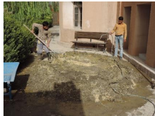
ت ۲. آخوره بستن خاک و الیاف کاه برای اختلاط با آب. مأخذ: نگارنده.
