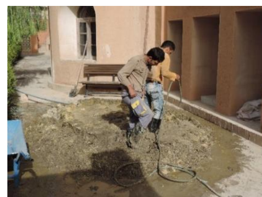
ت ۳. ورز دادن کاهگل با لگد کردن آن توسط نیروی انسانی. مأخذ: نگارنده.
