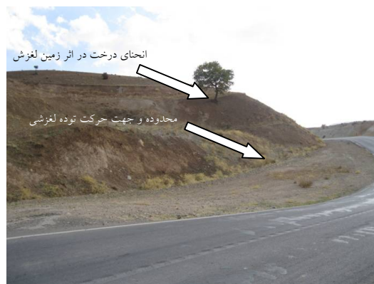
ت 2. نمایی از آثار حرکت زمین در کیلومتر 15+350 (دید به سمت شمال شرق).
