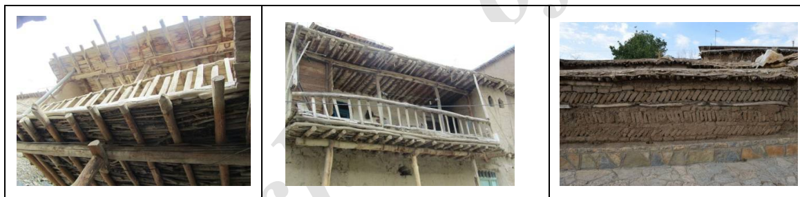
ت 7. تکنولوژی بومی ساخت ایوانها به همراه تنوع بافت خشتی در سکونتگاه بالک. منبع: نگارندگان.
