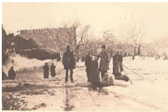
ت 2. جمع‌آوری برف و یخ و قرار دادن آنها در حوضچه‌های یخ‌ساز در یخدان‌های بدون گنبد. (منبع: هولتزر، 45:1355).
