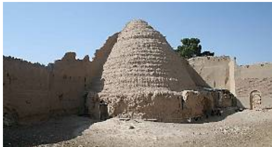
ت 9. موقعیت دیوار سایه‌انداز نسبت به مخزن و درگاه شرقی در یخچان محمدآباد (منبع: آرشیو میراث فرهنگی ناین، تاریخ عکاسی 1394/7/12).
