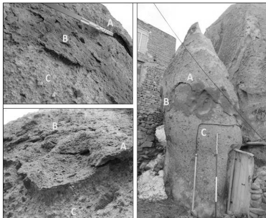
ت ۲. گونه‌های شاخص آسیب در معماری صخره‌ای کندوان، (A) تورق شدید با بیش از ۵ سانتی‌متر جدایش از بستر اصلی، (B) از دست رفتن زمینه، (C) تغییر رنگ و تاول.
