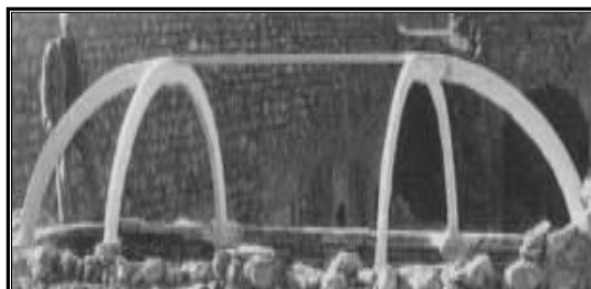
ت ۹. استفاده از قالب گچی برای ساخت تاق لی‌لی پوش با استفاده از مصالح سنگی (منبع: آرشیو شخصی دکتر فخار تهرانی).
