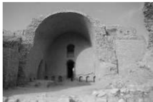
ت ۸. اجرای تاق آهنگ با استفاده از دیوار پشتواره. آتشکده فیروز آباد، استان فارس (منبع: نگارندگان).
