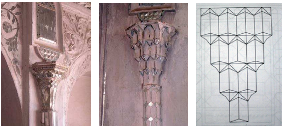
تصویر ۱۱. راست و چپ، شیک نوع مقرنس معمولی در سرستون، کتاب هنرگره سازی در معماری و درودگری، جواد، مأخذ: شفایی، ۱۳۸۰: ۲۳
