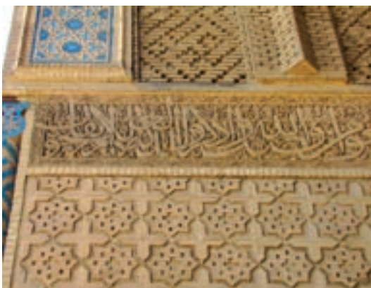
تصویر ۱۱. نقش اختر چلیپا با آجر در ایوان جنوبی مسجد ورامین. مأخذ: همان.
