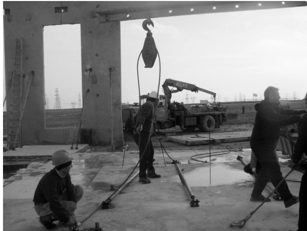
شکل ۴: تولید و نصب دیوارهای بتن مسلح و باربر در سیستم Tilt-up، شهر جدید پرد
