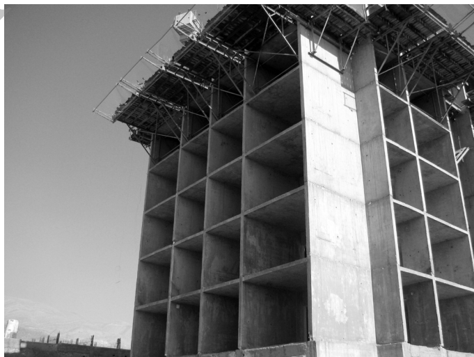
شکل ۲: صلبیت دیوارهای بتن مسلح و باربر سیستم قالب تونلی در برابر تغییرات، شهر جدید پردیس
