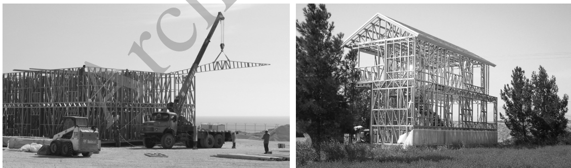
شکل ۳: به‌کارگیری اجزای مدولار و استاندارد در مراحل اولیه طراحی و ساخت و ساز با سیستم LSF
