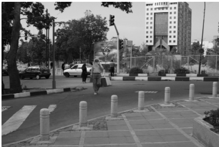
شکل ۹: فاصله کمتر از ۹۰ سانتیمتر بین میله‌های امنیتی
