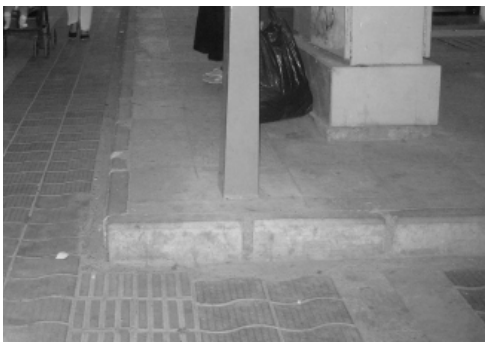
شکل ۲: قطع مسیر ویژه نابینایان در مناسب‌سازی
