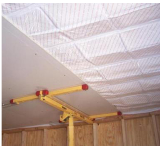
شکل ۲: نصب PCM بر روی سقف مدل
