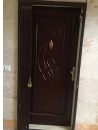
شکل ۸: نصب حفاظ آکاردئونی در درب ورودی
