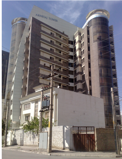
شکل ۵: نمونه‌هایی از ساختمان‌های بلند مسکونی در منطقه ۹ شهر مشهد (ساختمان مسکونی باران ۱)
