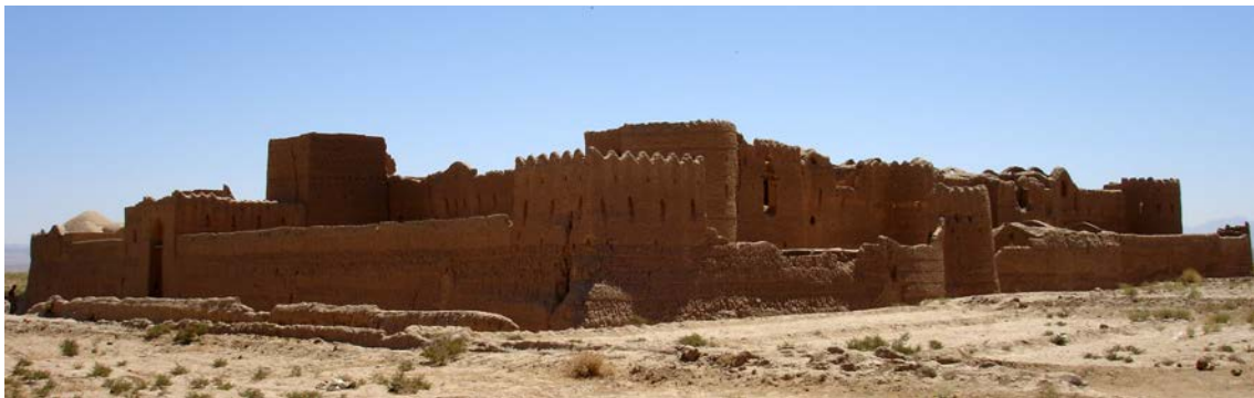
تصویر ۵. دروازه، خندق، حصار و برج‌های قلعه سریزد (مأخذ: ریاحی مقدم، ۱۳۸۷)
