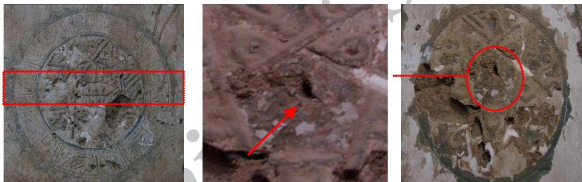
تصاویر ۲۰. نمایی از شمشه و اجرای دایره شمشه با خراش ظریف، نقوش انتهایی شمشه و قلم‌گیری نقوش با رنگ مشکی بسیار رقیق (مأخذ: نگارندگان)
