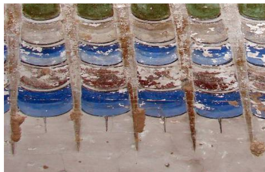
تصاویر ۲۸. خطوط اصلی شمشه با خراش‌اندازی بسیار ظریف و رنگ‌ها با رنگ مشکی قلم‌گیری شده و حد و مرز رنگ‌گذاری داخل شمشه با خراش ترسیم شده‌است. (مأخذ: نگارندگان)
