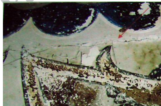
تصاویر ۱۴. خط اندازی و شیار به صورت دایره‌های متحدالمرکز برای اجرای شمشه (مأخذ: نگارندگان)
