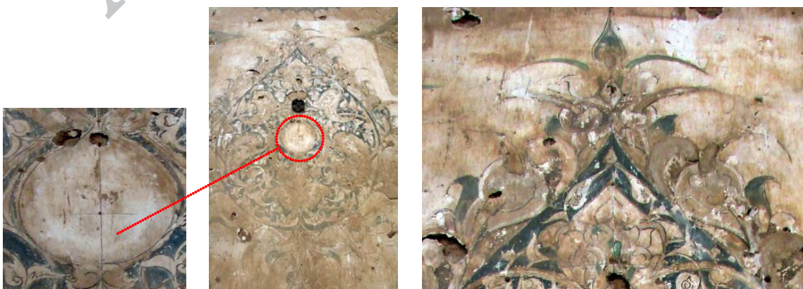
تصاویر ۲۲. نمایی از ترنج اجراشده روی جداره‌های داخل بقعه و تقسیم بندی‌ها برای اجرای ترنج (مأخذ: نگارندگان)
