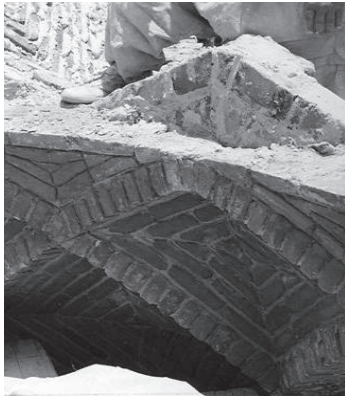
تصویر ۱۹. تبریز، پل بازار. رج‌ها را به سمت بیرون و بالا می‌افزایند (تهرانی، ۱۳۸۷).
