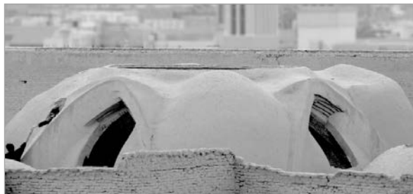
تصویر ۲۹. یزد، بانک شاهی، بام کاربردی، برجستگی های ۴ گوشه پوسته حفاظتی است (نگارندگان).
