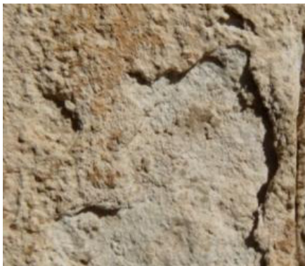
تصویر ۲۶. پوسته شدن سطح سنگ بر اثر فشار تبلور نمک‌ها (نگارندگان).
