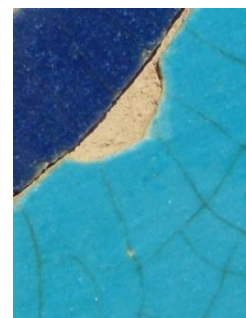
تصویر ۸. وجود ترک در لبه‌های کاشی و جدایش لعاب از سطح آن بر اثر ضربه تیشه کاشی تراشی (نگارندگان).
