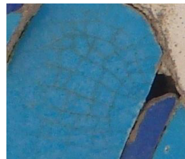
تصویر ۴. وجود ترک شبکه‌ای در سطح لعاب کتیبه (نگارندگان).
