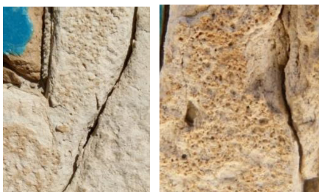
تصویرهای ۲۴-۲۳. وجود ترک در سنگ کتیبه (نگارندگان).
