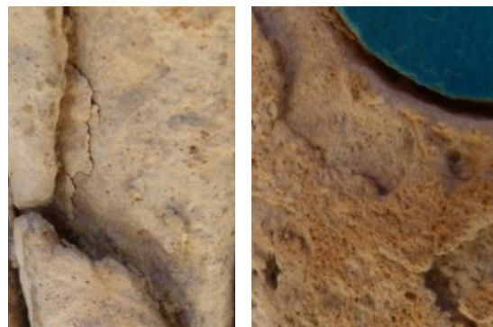
تصویرهای ۱۸-۱۹. پوسیدگی در سطح سنگ کتیبه (نگارندگان).
