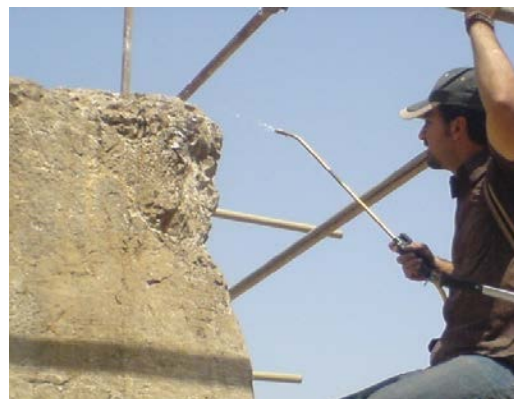
تصویر ۱۶. استحکام بخشی اثر با استفاده از اسپری آب آهک (نگارندگان).
