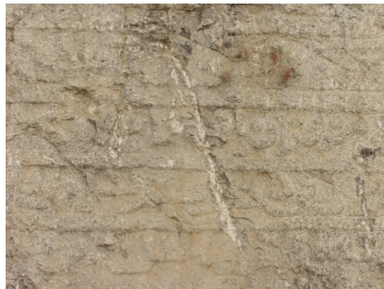
تصویر ۸. آسیب عمده شدید ایجاد شده با یک جسم تیز و سخت در بخش کتیبه (نگارندگان).
