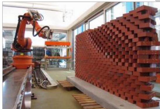
تصویر ۲. دیجیتال چینی دیوار آجری به وسیله ربات ۶ محوره در دانشگاه ETH (روش افزایشی)، (robotspodcast.com)
