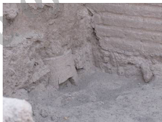
تصویر ۵. مصالح غیرسازه‌ای (کوزه‌ای سفالی) داخل یکی از دیوارهای حجره خشتی (نگارندگان)
