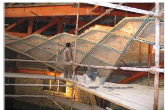
تصویر ۳. اجرای رسمی در قاب اسکلت فولادی (فتحی، ۱۳۸۵)
