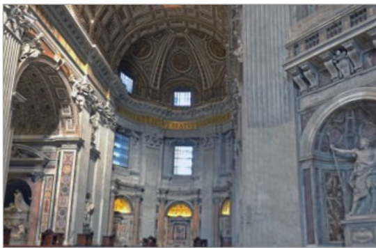
تصویر ۲۰. نحوه تأمین نور روز در فضاهای جنبی گنبدخانه مرکزی در کلیسای سن پیترو (URL: 5)
