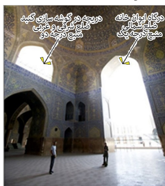
تصویر ۲۱. درگاه ورودی و دریچه گوشه سازی گنبد در مسجد عباسی (URL: 1)
