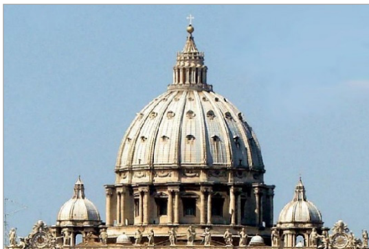
تصویر ۱۱. دریچه های ورود نور از تیزه، بدنه و گریو گنبد اصلی در کلیسای سن پیترو، نمای خارجی (URL: 4)
