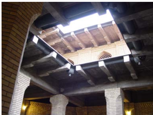
شکل ۱۷. نورگیر فضای وضوخانه که موجب تهویه نسبی آن نیز هست منبع: نگارندگان
