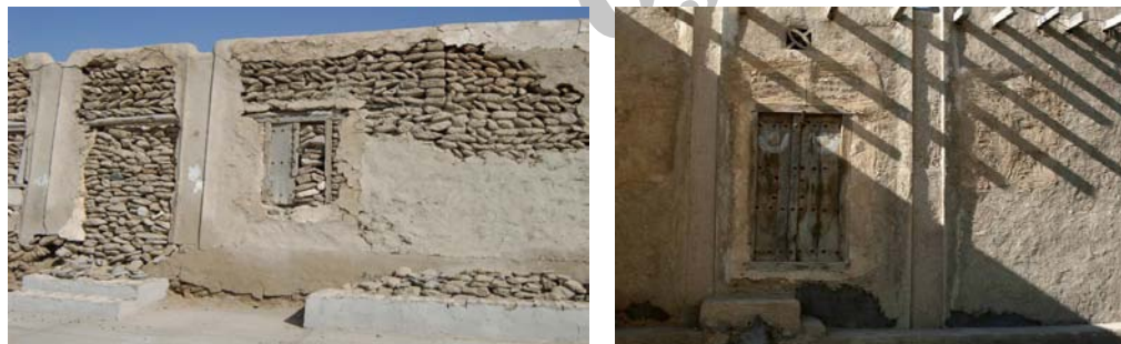
شکل ۸. الف و ب: استفاده از قطعه‌های همگون سنگ دج ماسه‌ای و یا شن ماسه‌ای از رسته سنگ‌های ته‌نشسته (رسوبی) در بافت مرکزی بندر لافت (تصویر چپ) و بافت حاصل از پوشش نهایی (تصویر راست)
