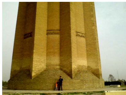
شکل ۳. پشتبندهای ایجاد شده بر بدنه برج قابوس منبع: engmmajidee.blogfa.com
