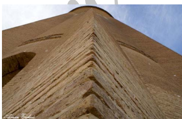
شکل ۵. پشتبندهای ایجاد شده بر بدنه برج قابوس منبع: engmmajidee.blogfa.com
