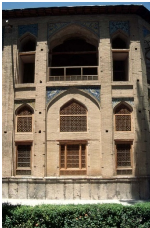
شکل ۳. نمای آجری بنا
