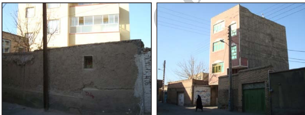
شکل‌های ۴ و ۵. عدم مطابقت ساختمان‌های قدیمی و نوساز در محله خیابان
