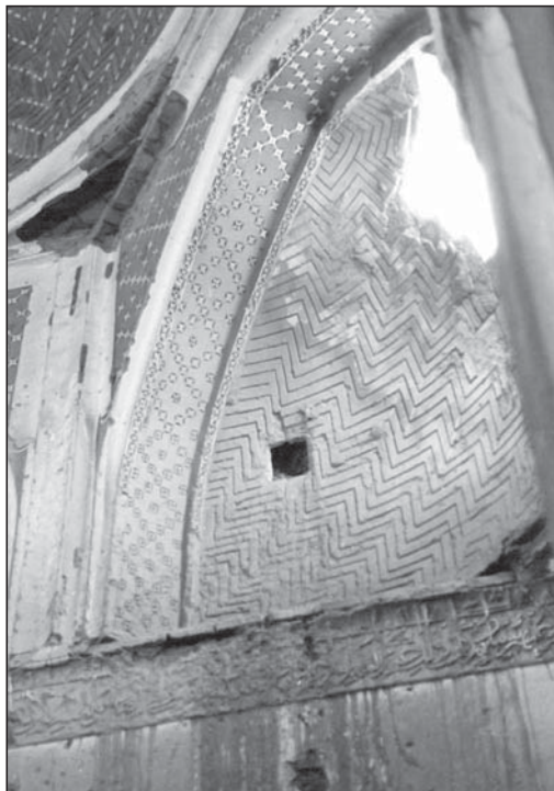
شکل ۶. داخل گنبدخانه بنای رشت خوار منبع: O'Kane, 1987, 27. 6
