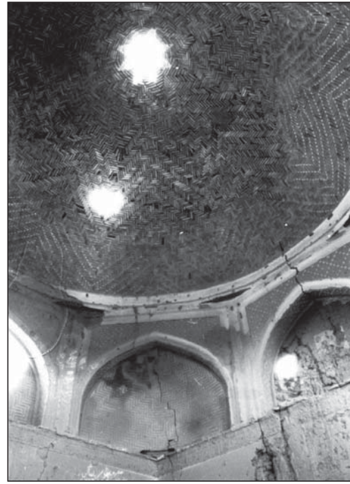
شکل ۲۹. داخل گنبدخانهٔ بنای رشت‌خوار منبع: O'Kane, 1987, 27. 5
