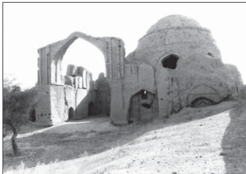
شکل ۹. ایوان و گنبدخانه بنای رشت‌خوار
