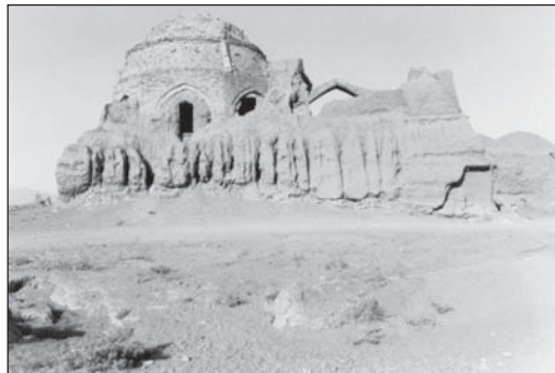
شکل ۸. نمای بنای از جنوب
