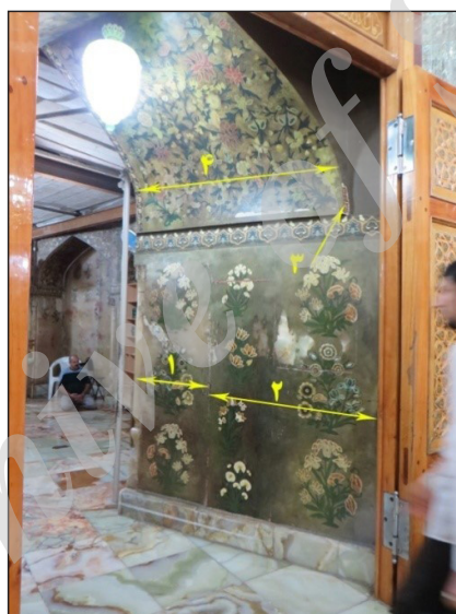
شکل ۸. ورودی جدید در سمت جنوب شرقی بقعه شاه‌عباس ثانی، ۱- سنگ مرمر لیمویی قدیمی، ۲- سنگ مرمر اضافه شده به رنگ سبز، ۳- بخشی از اسکلت فلزی زیر طاق، ۴- سقف یکپارچه با تزئینات کامل
