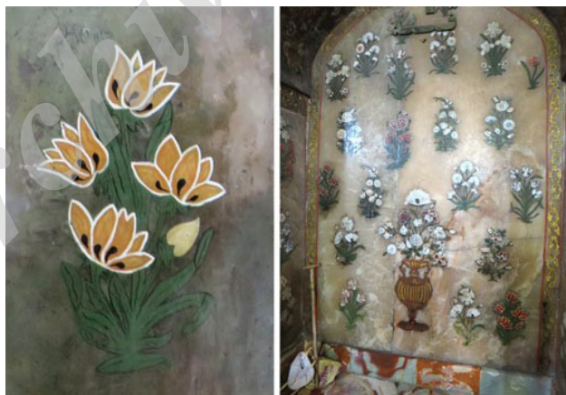
شکل ۱۳. (راست): بخش‌های بازسازی شده نقاشی‌های ازاره سنگی دیوار جنوبی با ظاهری نامناسب؛ (چپ): نمای نزدیک بخشی از مرمت نامناسب
