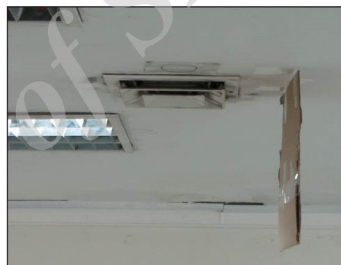
شکل ۸. ایجاد تغییرات اطراف دریچه‌های تهویه مطبوع با استفاده از مصالح سبک (کارتن مقوایی)
