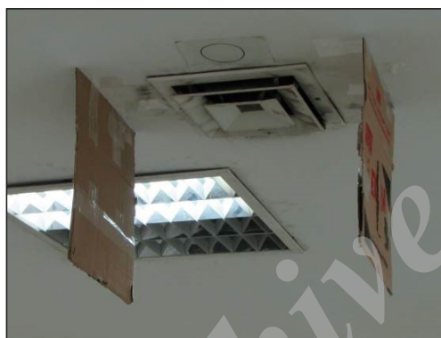
شکل ۸. ایجاد تغییرات اطراف دریچه‌های تهویه مطبوع با استفاده از مصالح سبک (کارتن مقوایی)
