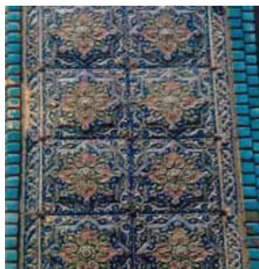
تصویر ۱۷: «کاشی منقوش گود و برجسته زیر رنگی» مقبره قیرآقا، خیابان سیروس تهران (دوره قاجاریه)
