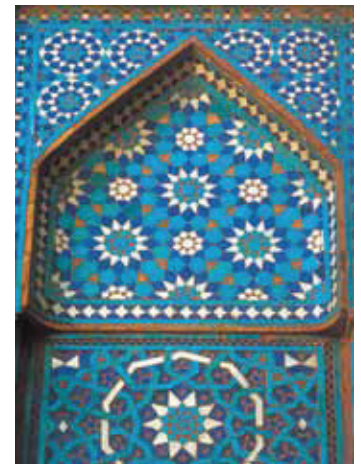
تصویر ۸: کاربرد کاشی پیش‌بر در قاب‌های مثلثی، ایوان مسجد کبیر یزد (دوره صفویه) (اسکلت بنا از دوره آل مظفر)
