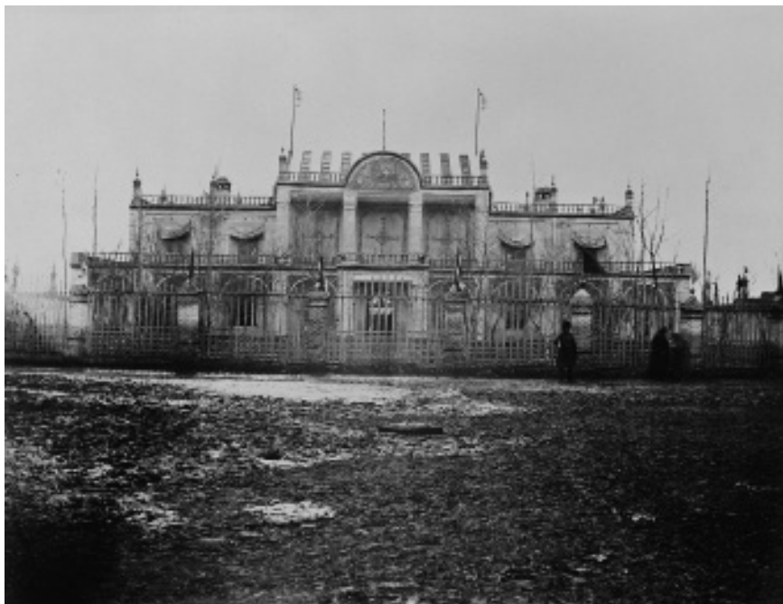
تصویر ۳: نمای شمالی مهمان‌خانه قزوین (مأخذ: آلبوم‌خانه کاخ گلستان)
