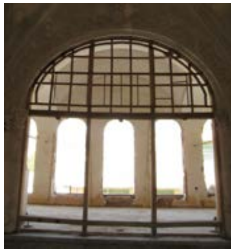
تصویر ۳: چهارچوب اُرسی داخل قصر عمارت خسروآباد در حال مرمت که تمام جزئیات آن باز است. با کتیبه قوس دار، وادارها و پاخور یا پاشنه
