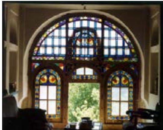
تصویر ۵: نحوه بازکردن یک لته از سه لته اُرسی اتاق گوشوار ضلع غربی عمارت اصف (خانه کرد)
