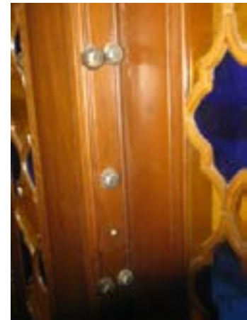
تصویر ۲۰: گل‌میخ‌های استفاده‌شده در اُرسی موزه سنندج تصویر ۲۱: دستگیره‌های فلزی برای بازکردن لنگه اُرسی موزه سنندج
