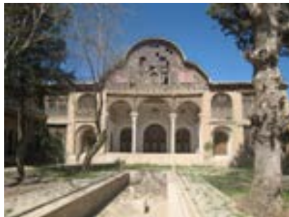
تصویر ۱۰: نمای ضلع غربی حیاط اصلی عمارت مشیردیوان سنندج. در طنبی و در زیر ایوان سه اُرسی، در دو سوی ایوان، در اتاق‌های گوشوار و سه‌دری‌ها در بالا و پایین اُرسی‌هایی به فراخور نصب شده است.
