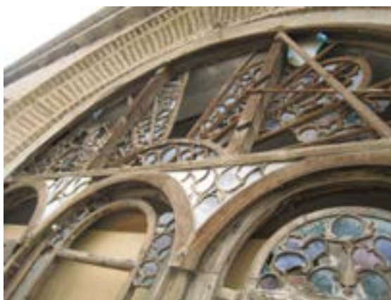
تصویر ۱: نمای پاتاق یا کتیبه با قوس نیم‌دایره اُرسی ضلع شرقی عمارت مشیردیوان سنندج
