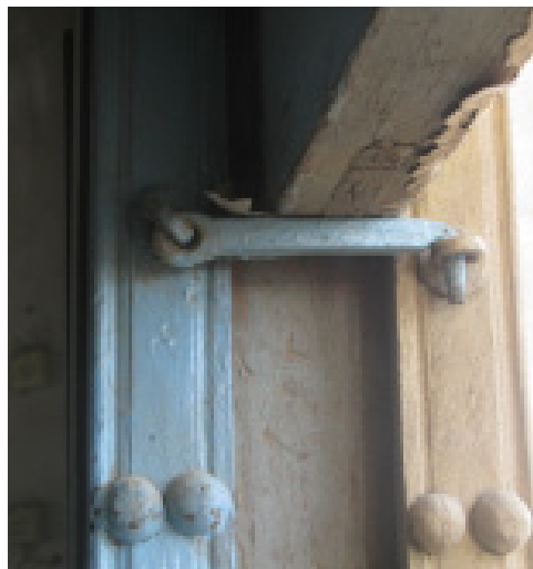
تصویر ۴: نحوه نگهداری لنگه اُرسی عمارت خسروآباد با خروسک فلزی
