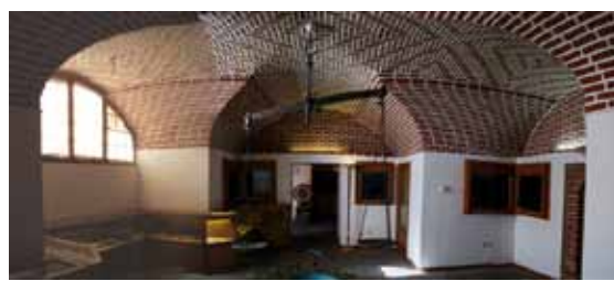
تصویر ۹: نمایی از حوضخانه در زیرزمین بخش بیرونی مجموعه‌خانه
