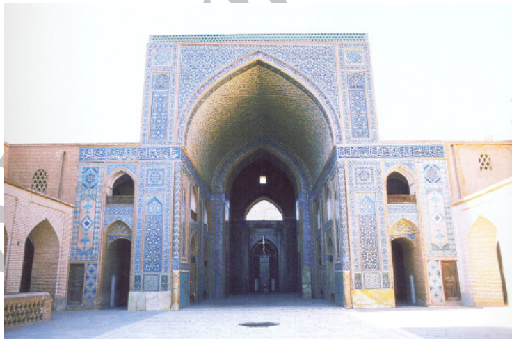
تصویر ۳: طاق آهنگ ایوان مسجدجامع یزد که پیرنیا قوس مقطع آن را چفد چمانه معرفی کرده است (حاجی‌قاسمی ۱۳۸۹، ج. ۸: ۱۶۹).
