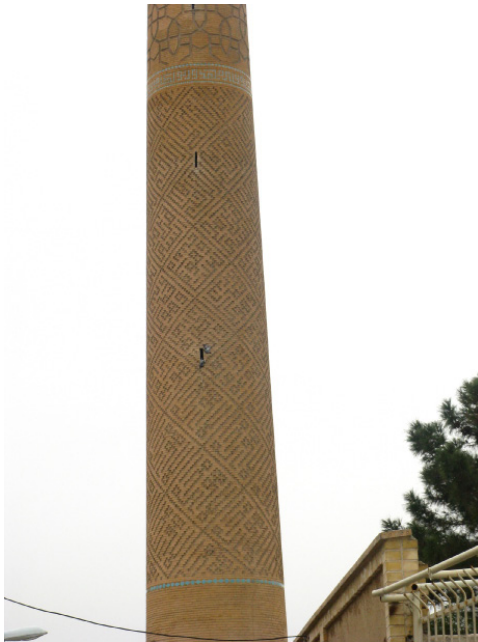
تصویر ۵: ساقهٔ میل منار ساریان شامل ۱. مربع لوزبندی‌ها ۲. خط کوفی بنایی معقلی متداخل ۳. کتیبهٔ خط کوفی ۴. نقوش گره هندسه آجری از تصویر قبل ۵. بی‌توجهی به هویت و ارزش‌های این اثر بزرگ تاریخی از طرف سازمان میراث فرهنگی و شهرداری اصفهان
