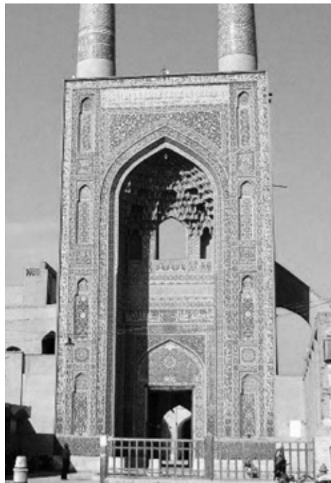
تصویر ۱۵: سردر شرقی مسجد جامع یزد پس از مرمت و تکمیل کاشی‌کاری سطوحی که اجرا نشده مانده بود.
