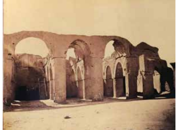
تصویر ۱۲: سوی قیبله تاریخانه دامغان در ۱۹۱۳ م/۱۲۹۱ ش. قوس‌های رو به صحن و طاق شبستان در یک تراز قرار دارد (سمسار و سرائیان ۱۳۸۲: ۲۹۴).
