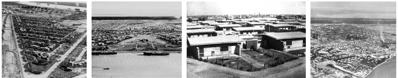
تصویر ۲: نمایی از خانه کارگران و کارمندان در محلات بریم (سمت راست) و بورده (سمت چپ) در آبادان (مجله آرشیوتکت ۱۳۲۶)
