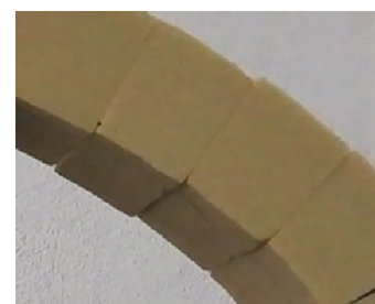
تصویر ۱۸: لبه‌های قطعات قوس دقیق نیستند و به داخل خم شده‌اند.
