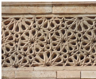
تصویر ۹: دست‌اندازهای مشبک سنگی در گنبد سلطانیه
