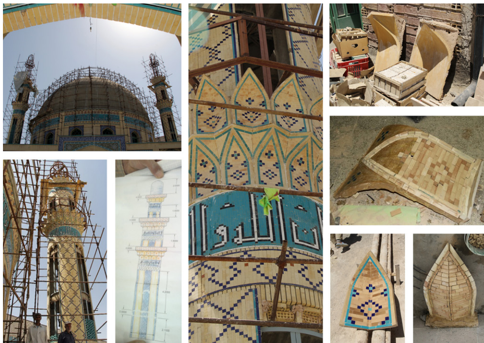
تصویر ۶: مناره‌های مسجد صاحب‌الزمان سپاهان‌شهر اصفهان و بعضی از مراحل ساخت مقرنس آن
