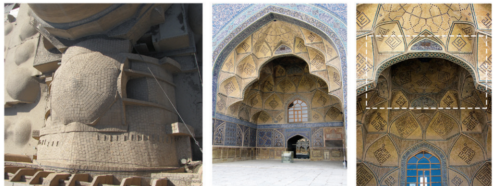
تصویر ۳: تصویر و بازنمایی سه‌بعدی پوشش پتکانه مسجد جامع اصفهان که لنگه‌طاق جلوی دهانه در آن نشان شده است.
