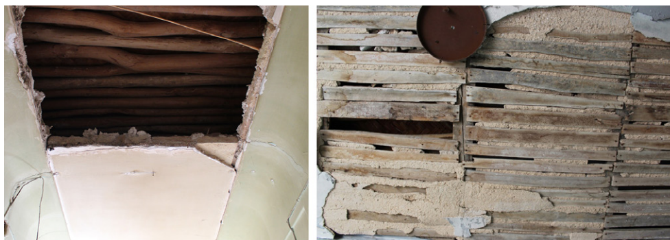
تصویر ۱۱: سقف کاذب چوبی یا آجری برای پوشش سقف تیرپوش چوبی با گچ در راهروهای خانه‌های شماره ۱ و ۱۰
