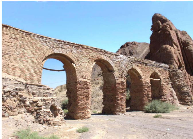
تصویر ۱۲: پل آب‌بر خرائق. نمونه‌ای از سازه‌ی پل که به‌منظور انتقال آب ساخته شده است.
