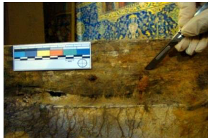
تصویر ۴. جزئیات عامل پوسیدگی نرم بر روی در چوبی، منبع: نگارنده اول
