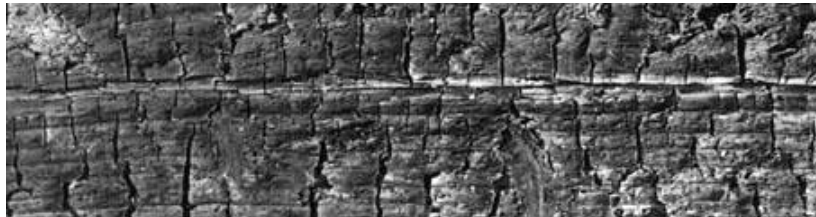
تصویر ۱. حمله پوسیدگی نرم به یک برج چوبی خنک کننده، منبع: اسمیت، ۲۰۰۶، ص ۱۴۳
