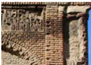
تصویر ۷: ساخت بنا با خشت و نما کاری آن؛ ستون مدور ضلع شمالی شرقی و قسمتی از کتیبه ضلع شرقی گنبد سرخ (مأخذ: نکارندگان)
