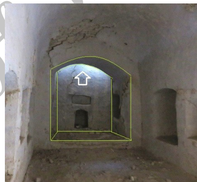
تصویر ۶ فضاهای خالی حدفاصل دریچه‌های ورودی و ابتدای کانال‌های داخلی یکی از بادگیرها، در اتاق پشت بادگیر (مأخذ: نگارندگان ۱۳۹۴)
