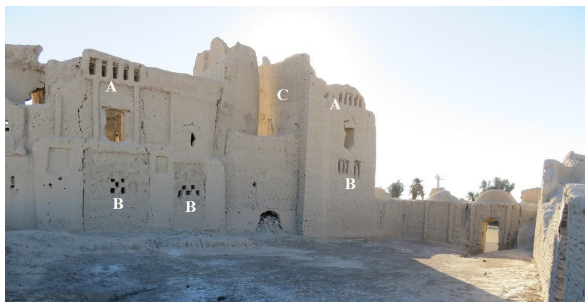
تصویر (۵) A: بادگیرهای نمای خارجی، پشت ساختمان بخش مرکزی در لبه‌ی پشت بام، B: بادگیرها در بخش میانی دیوارها به صورت منافذ مشبک مربع و مستطیل شکل و C: ورودی جریان باد در آس‌باد (نگارندگان، ۱۳۹۴)
