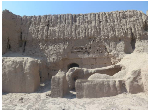
شکل ۱۰. ورودی تاریخی محله از نمای درونی، دید از شمال، بقایای صندوقه‌های خشتی در پیشانی ورودی و اتاق‌های محافظ و کنترل‌کننده‌ی خروج از محله در دو سمت ابتدای گذر تاریخی (مأخذ: نگارندگان)
